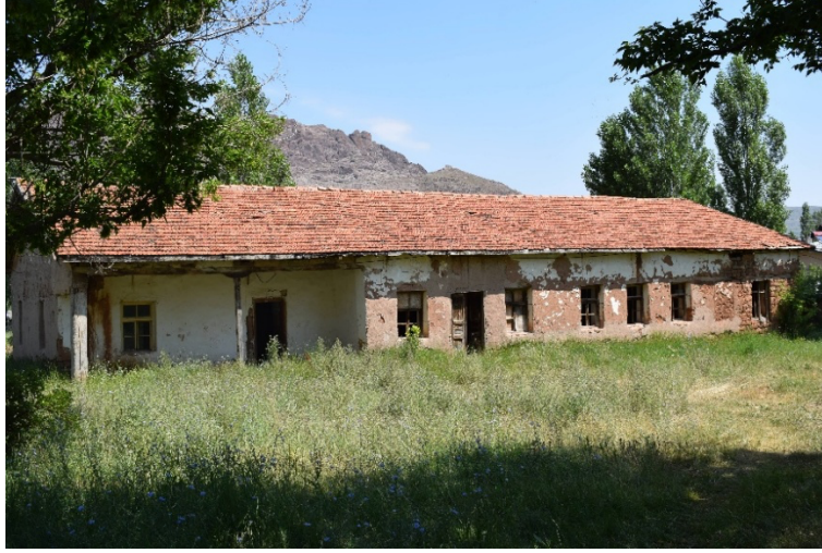
Fotoğraf 2: Kızılcaışla Köyü İlkokulu Güney Cephesi
