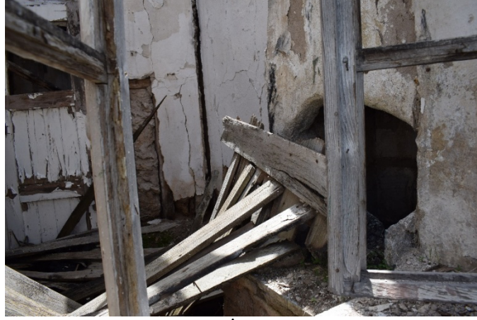
Fotoğraf 23: Yolkaya Köyü İlkokulu Lojmanı, Mutfak
