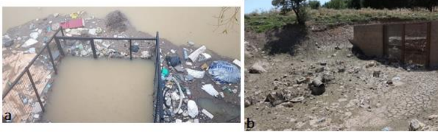
Şekil 13: a) Hamursuz I Düdeni ve düdendeki menfez önünde yer alan ızgaraların düdenin tıkanmasını önleme noktasındaki önemini gösteren bir resim. b) Tıkalı olan Hamursuz II Düdeni.
