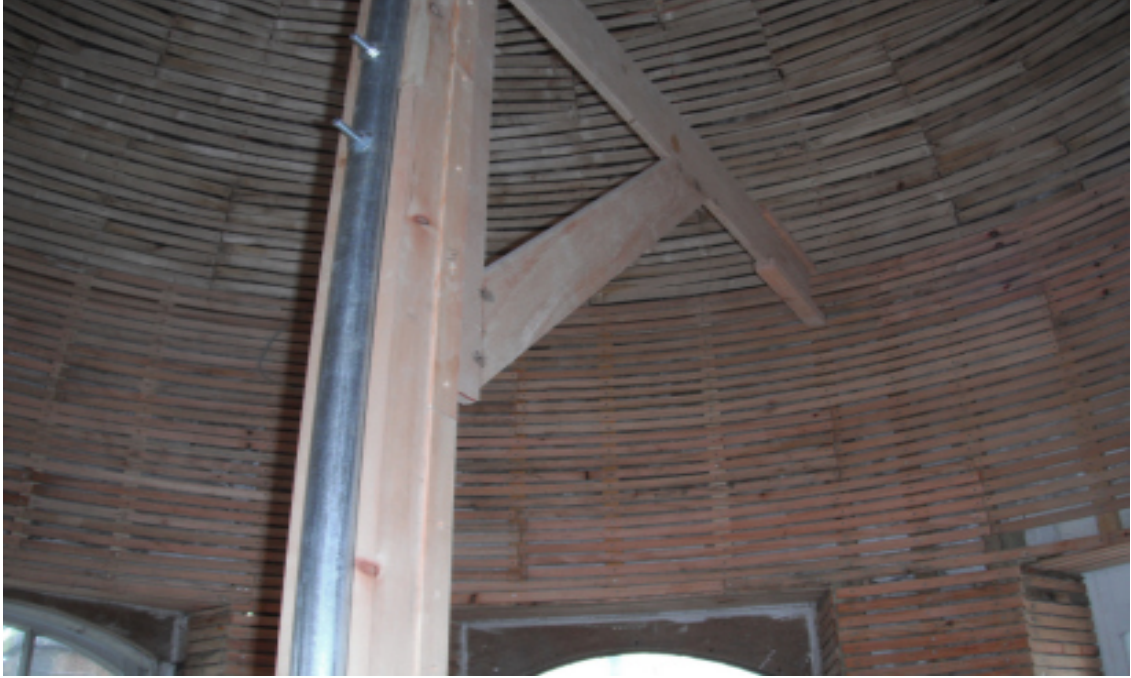
Fotoğraf 1. Bağdadi kubbe iç görünüm
