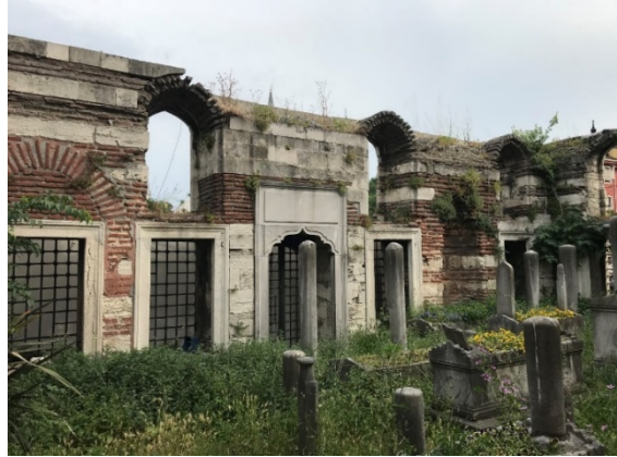
Foto 8. Türbe Güney Duvarı.
