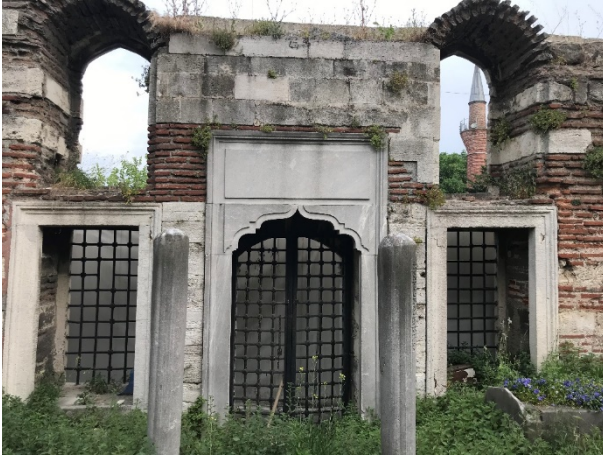
Foto 3. Türbe Güney Girişinin İçten Görünüşü.
