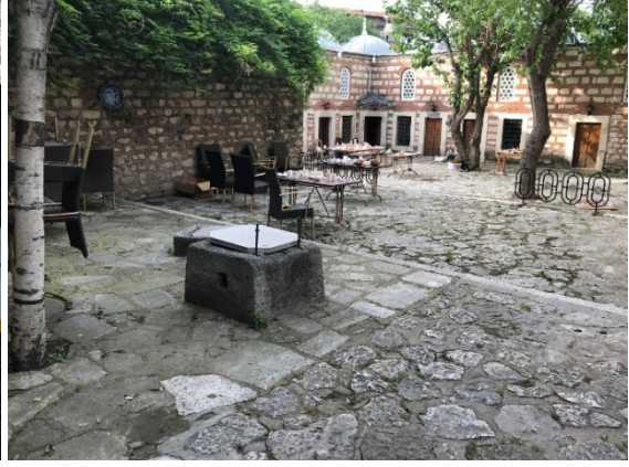
Foto 15. Tekkenin Kuzeydoğudan Görünüşü.
