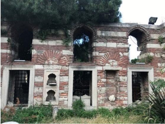
Foto 7. Türbe Batı Duvarı (İçten)
