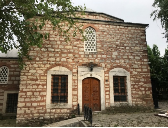
Foto 16. Mescidin Kuzey Cephesi.
