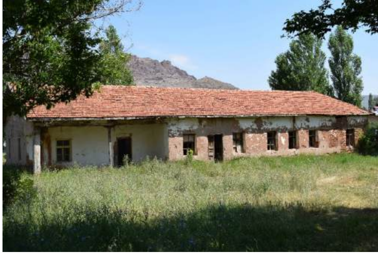
Fotoğraf 2: Kızılcaışla Köyü İlkokulu Güney Cephesi
