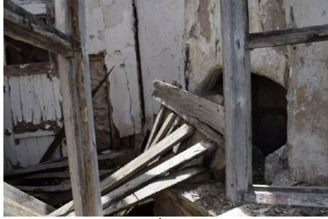
Fotoğraf 23: Yolkaya Köyü İlkokulu Lojmanı, Mutfak
