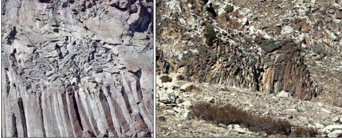
Şekil 12: Çalışma Alanında Tespit Edilen Düzensiz Sütunumsu Yapılar.
