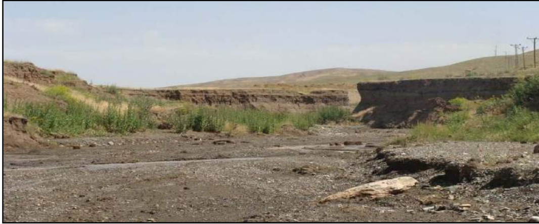
Foto 12. Karakoç Deresinde Sel Sonucu Zeminde Oluşan Toprak Yarılımları
