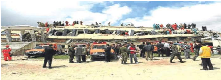
Şekil 2: Çeltiksuyu YİBO Binası Yıkılma Görüntüsü ( https://www.milliyet.com.tr/ )
