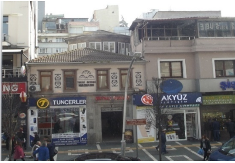
Res:4/2 Erkekler bölümü sıcaklığı göbek taşı
